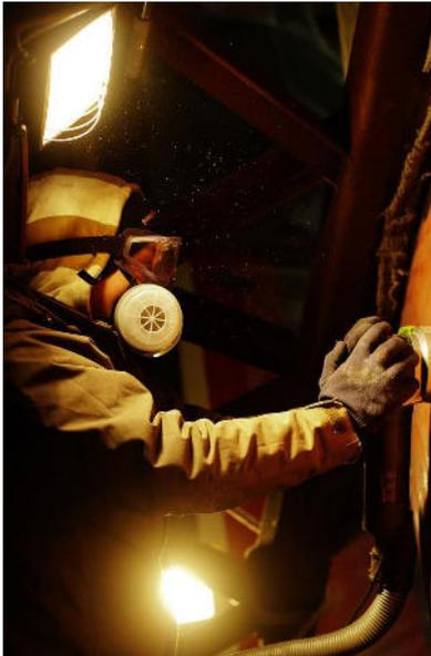
Schichten Antifouling und verschiedene Primer mußten bis auf das Gelcoat runter. Damit hatten wir auch die Möglichkeit, zwei leicht eingedrückte Stellen auszubessern, die durch eine ungünstige Lagerposition auf den Böcken im Winter der Vorjahre entstanden waren.
